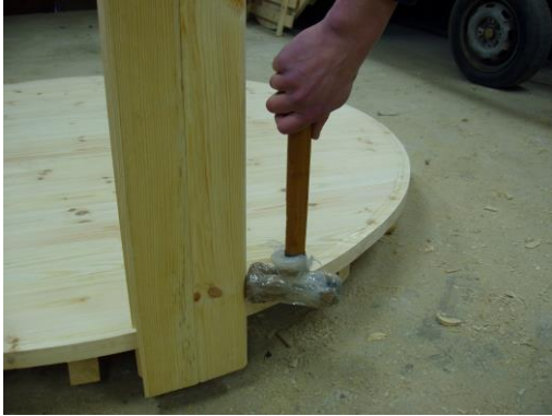
Afbeelding 3. Het plaatsen van de duigen
