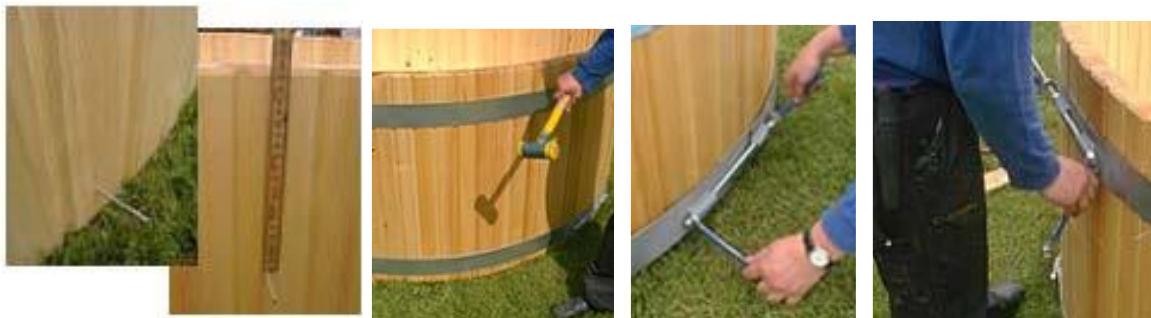
Afbeelding 4. Het aanbrengen van de hoepels.
